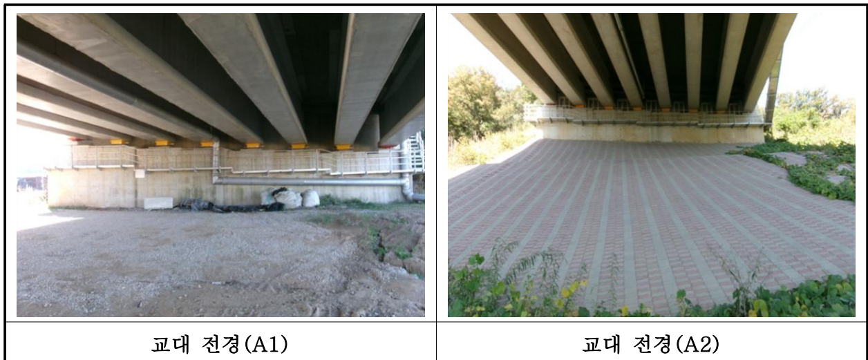
【사진 19.3.8】 교대 전경
