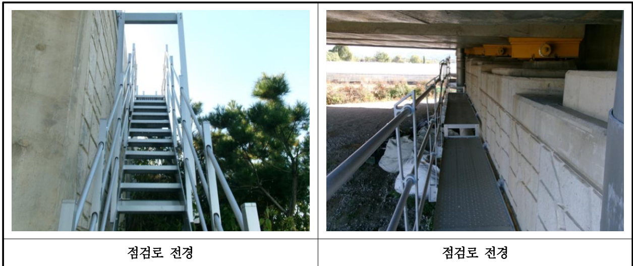
【사진 19.3.25】 교량 점검시설 전경
