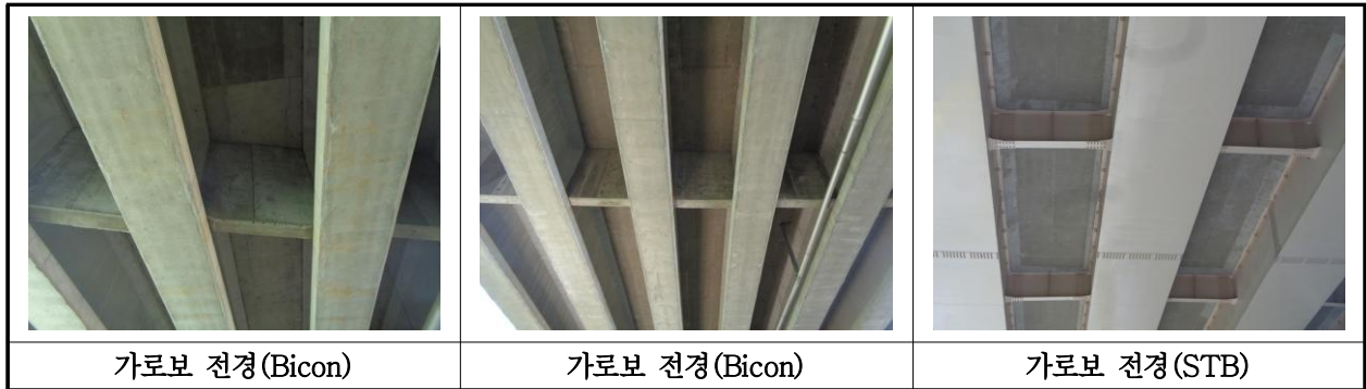
【사진 19.3.6】 가로보 전경
