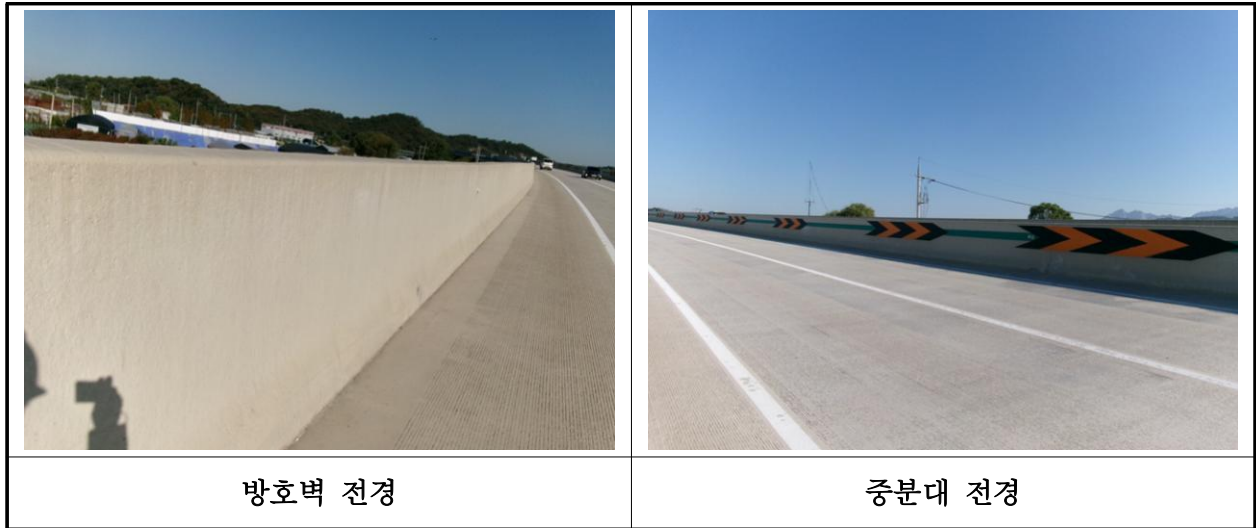
【사진 19.3.23】 방호벽 및 중앙분리대 전경
