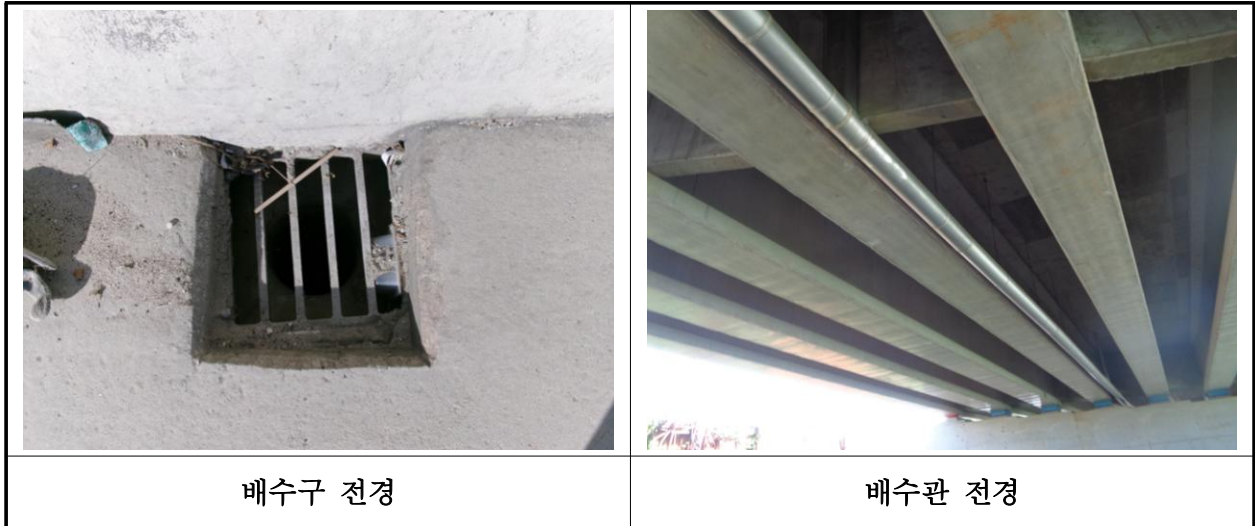
【사진 19.3.21】 배수시설 전경
