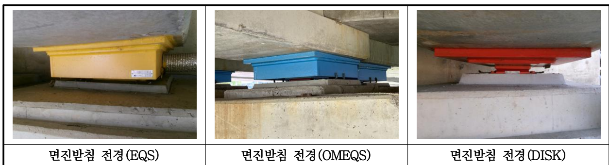
【사진 19.3.12】 교량받침 전경
